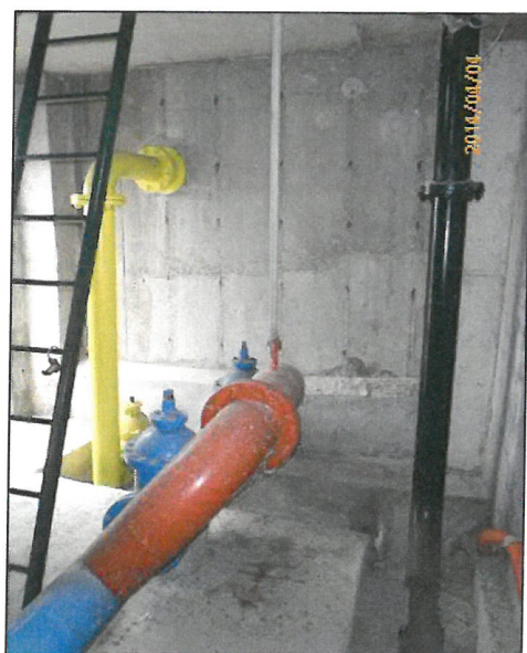
Illustration n°8 : Chambre de vannes du réservoir du Belvédère
