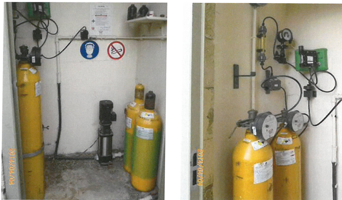
Illustration n°3 : Système de traitement au chlore gazeux
