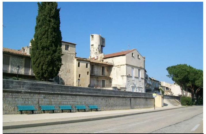
Vue de la digue prise depuis l'avenue Jean Moulin
